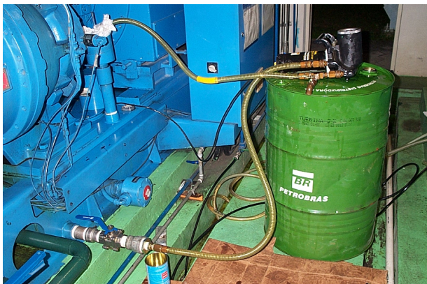
Figuras 13/14 – Filtros de óleo lubrificante ISO VG 460: baixa vazão
